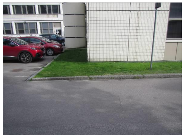
Kuva 12 Pihakannen lähin sadevesiviemäri on parkkipaikan puolella, melko kaukana pihakannesta.
