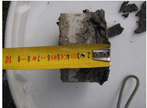
Kuva 5 Bitumikermi ja kermin yläpuolinen betoni.
