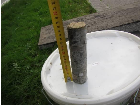
Kuva 2 Kantavasta betonilaatasta otettu näytekappale.
